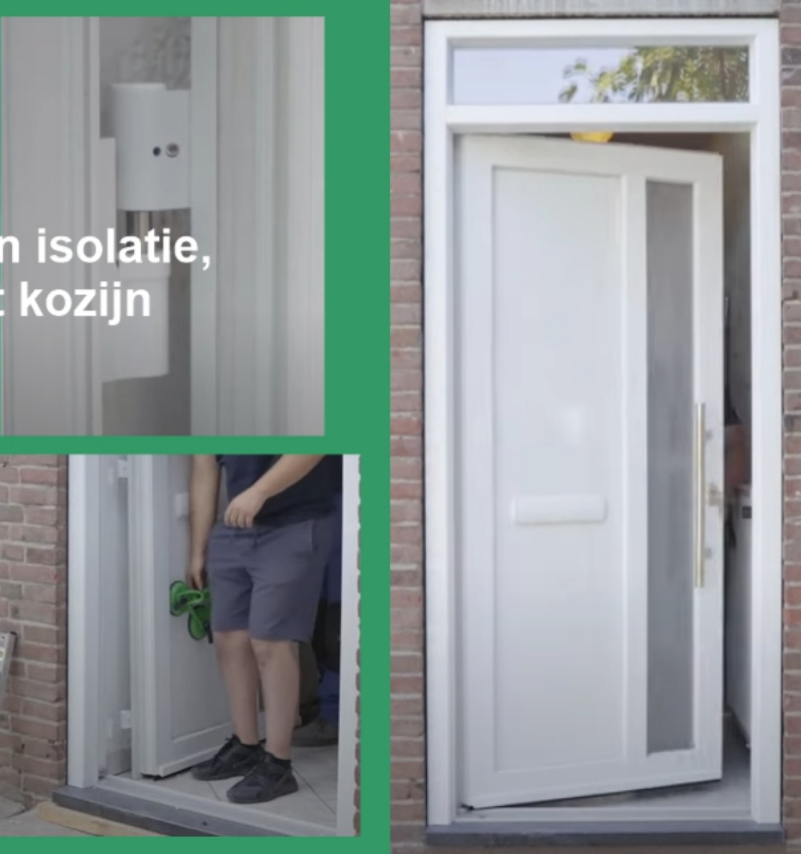
13. Plaats het draaideel en stel eventueel scharnieren af
