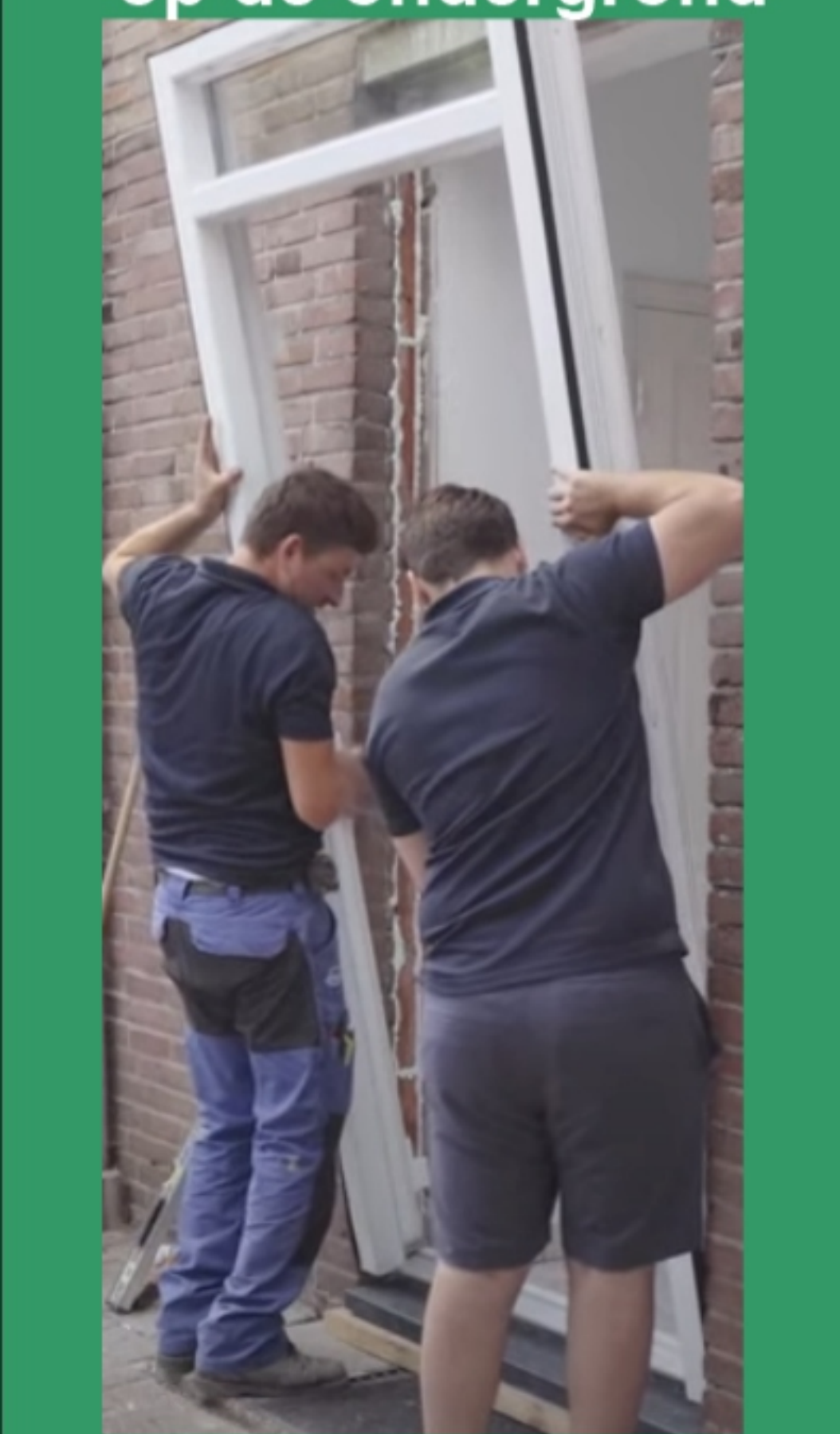
8. Plaats het kozijn waterpas op de ondergrond
