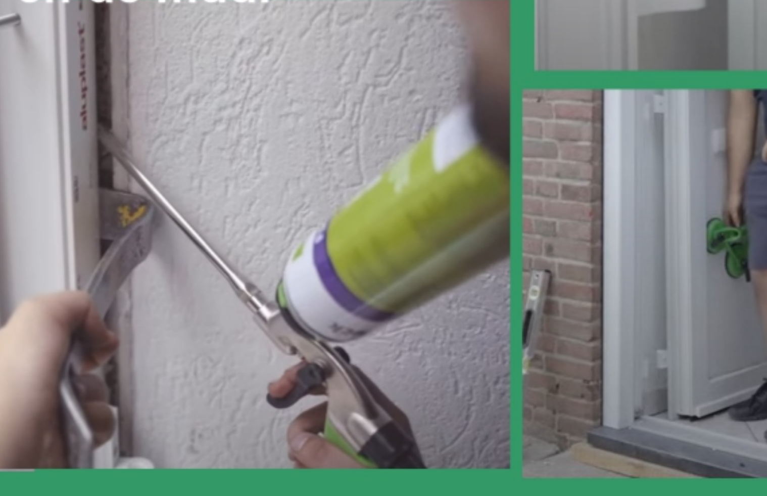
12. Voor stevigheid en isolatie, gebruik pur tussen het kozijn en de muur
