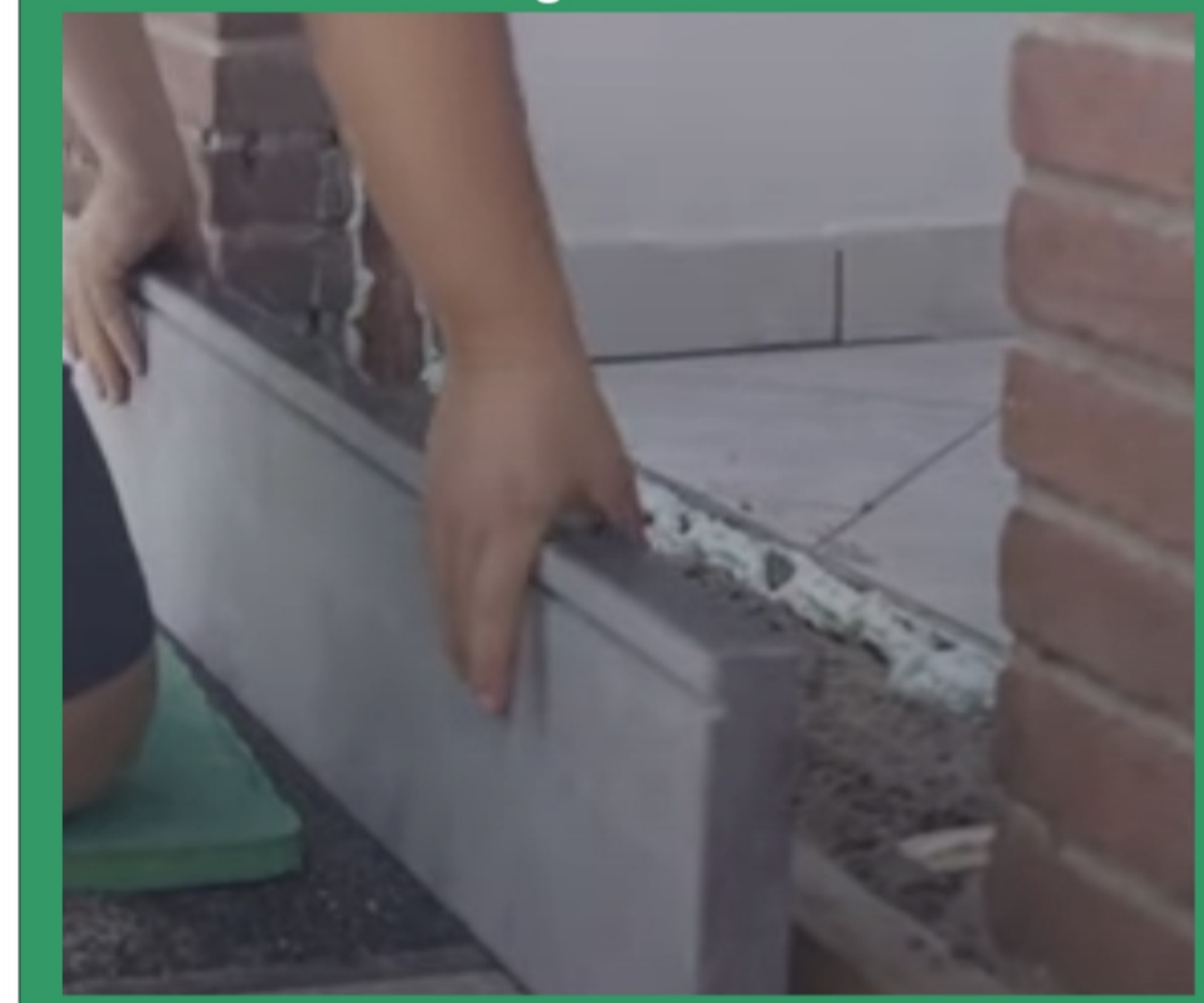
8. Plaats het kozijn waterpas op de ondergrond
