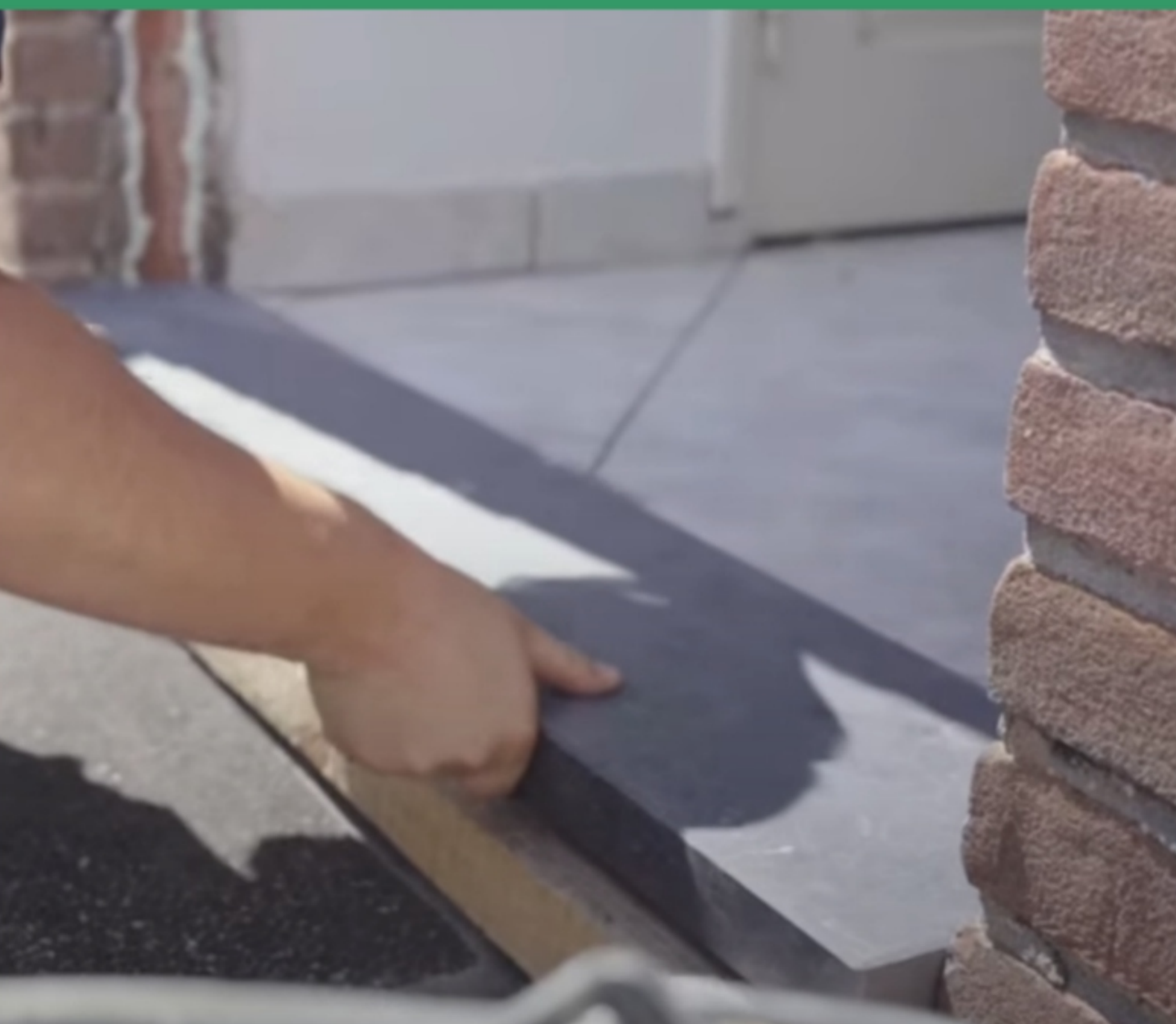
9. Kozijn voorbereiden: -1ste links en recht 10-15 cm van onder (vlak onder het 1ste scharnier) -2de links en rechts 30-40 cm hoger -3de links en rechts 30-40 cm hoger -4de links en rechts 10-15 cm vanaf boven
