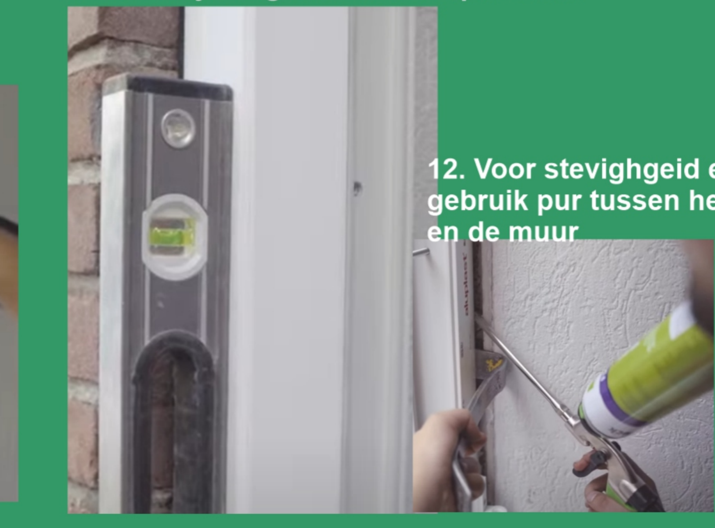
11. Controleer na het indraaien van elke schroef of het kozijn nog steeds waterpas staat
