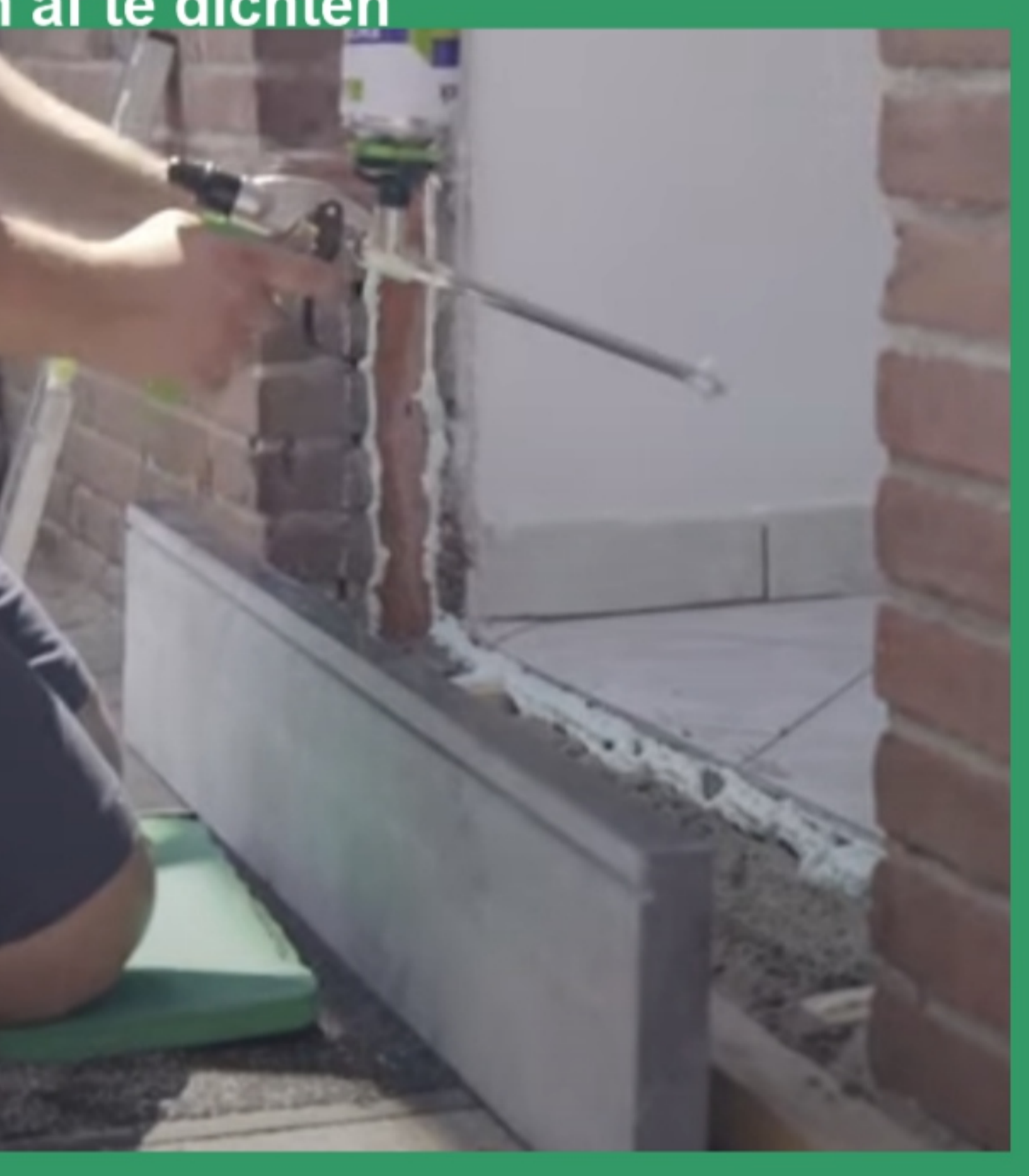
8. Plaats de deur met de deurdrempel waterpas op de geprepareerde ondergrond met isolerende kit daartussen.,
