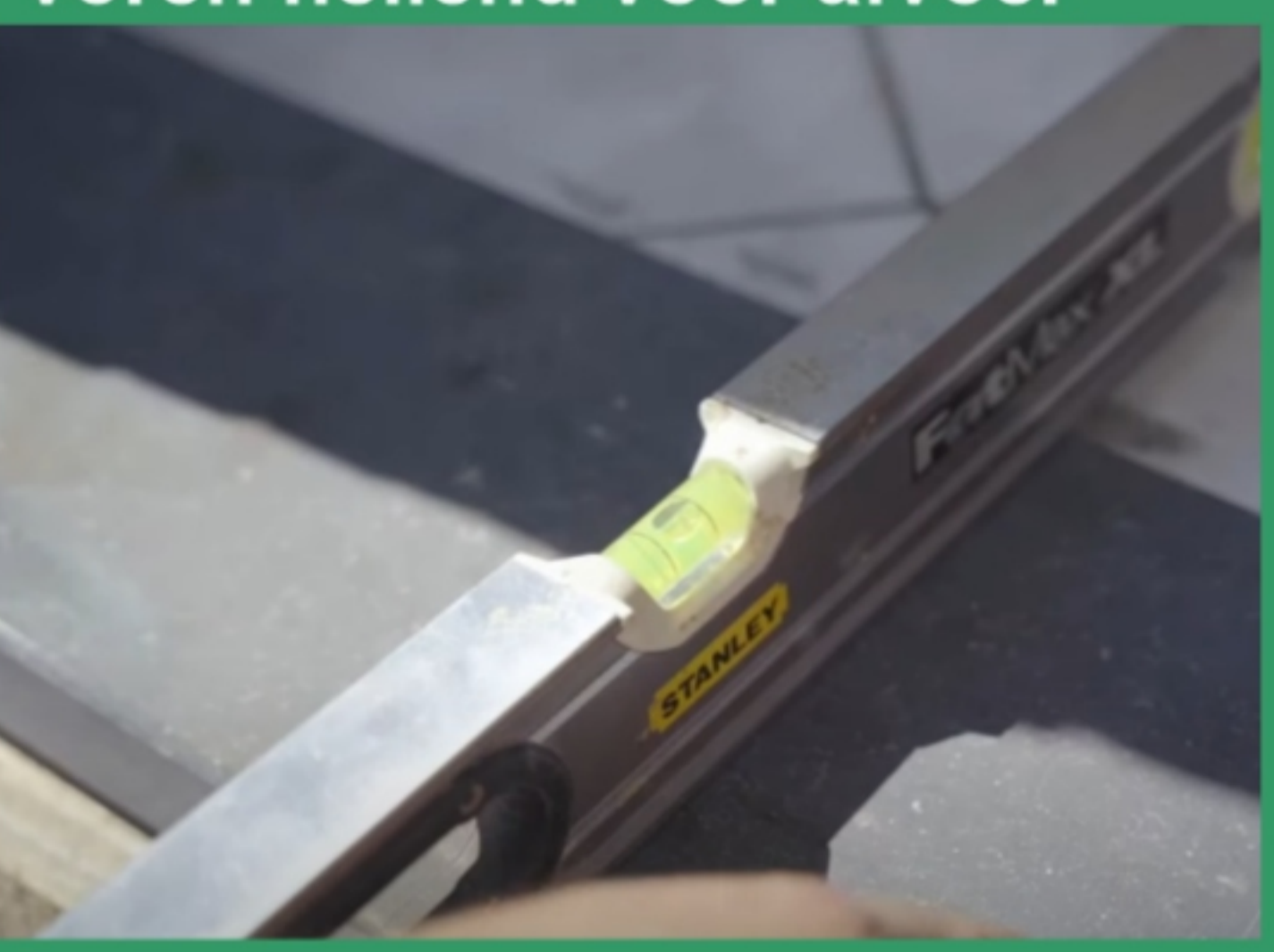
4. Stel deze onderdorpel waterpas en een beetje naar voren hellend voor afvoer
