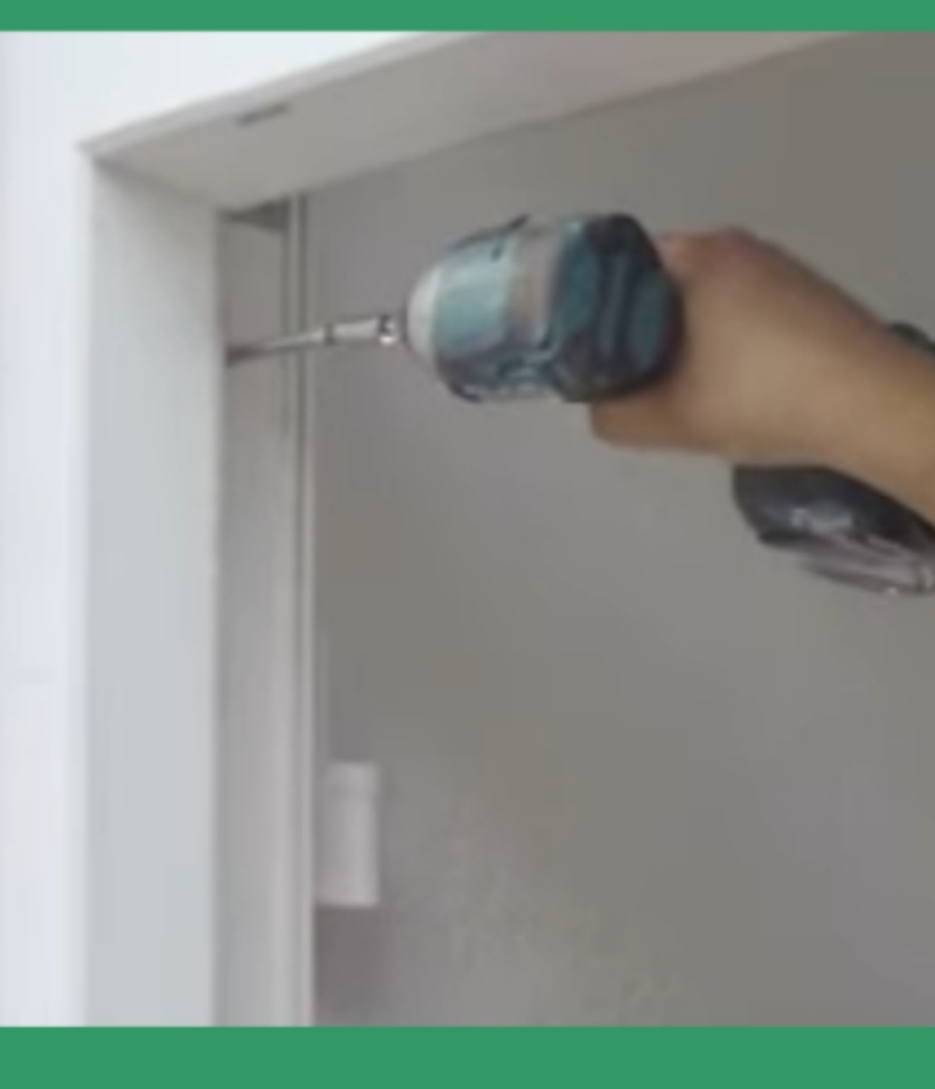
10. Schroef het kozijn vast, begin aan de scharnier-zijde, eerst boven dan onder en dan in de midden
